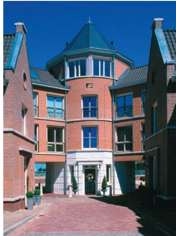
Town center architecture: Rob Krier • Christoph Kohl Architekten.
